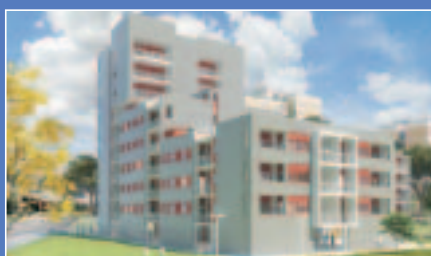
INTERVENTO A PIETRALATA IN VIA MATTEO TONDI
